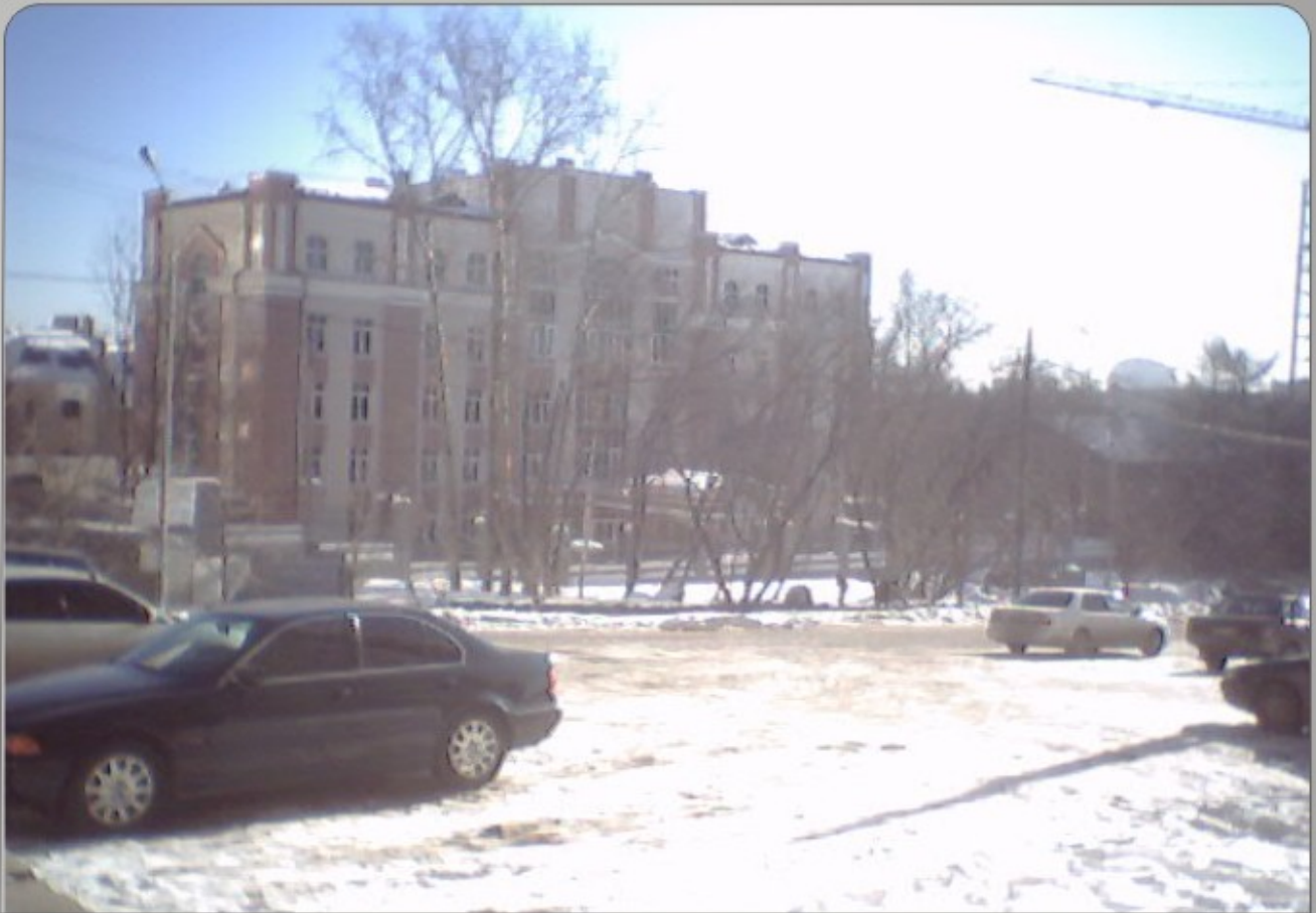
Хирургическая клиника по ул. Шейнкмана, 115 в Ленинском районе г. Екатеринбурга
